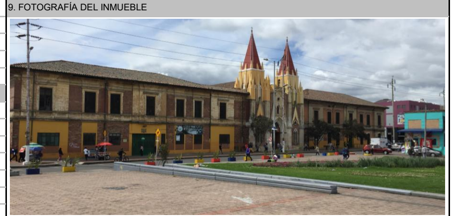
Fuente: Equipo Fotografía PEMP Patrimonio Inmueble
